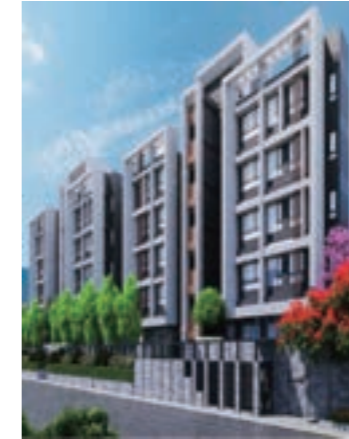
山汧藏(內湖) 富樂群建設 5F/B2F 2棟RC
