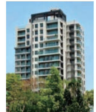
江之翠(板橋) 家勝建設 15F/B4F RC
