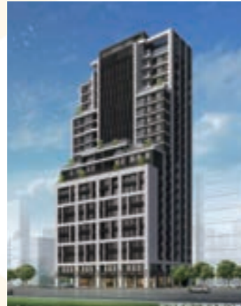
新碩華悅(台北) 新碩建設 22F/B6F SC
